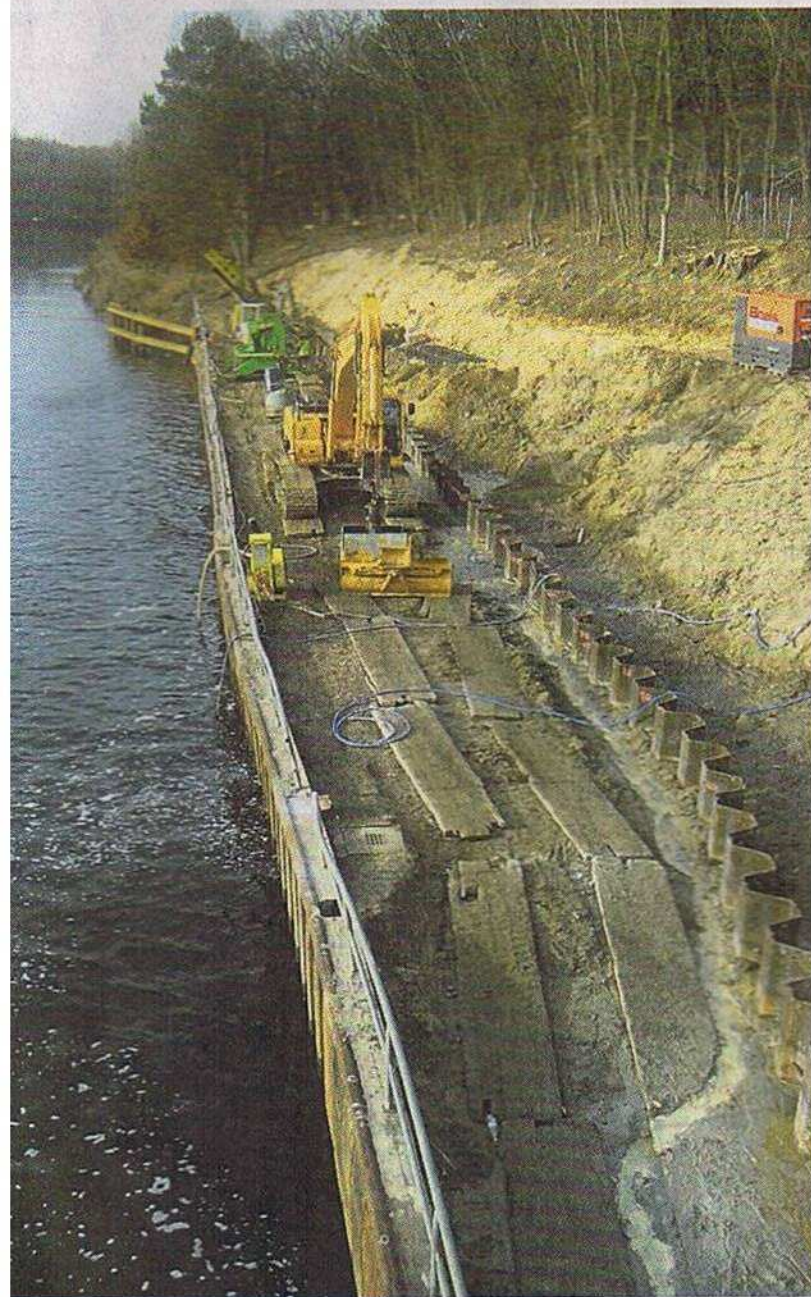
Die Einbringung der neuen Spundwand wird ebenfalls abgegraben.
